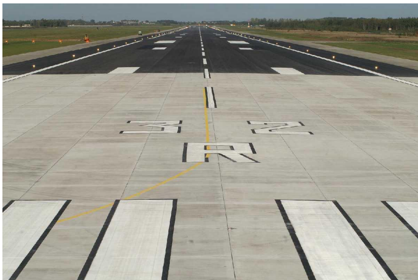
22 pav. Šiaulių oro uosto kilimo ir tūpimo takas (RWY 14L/32R)
