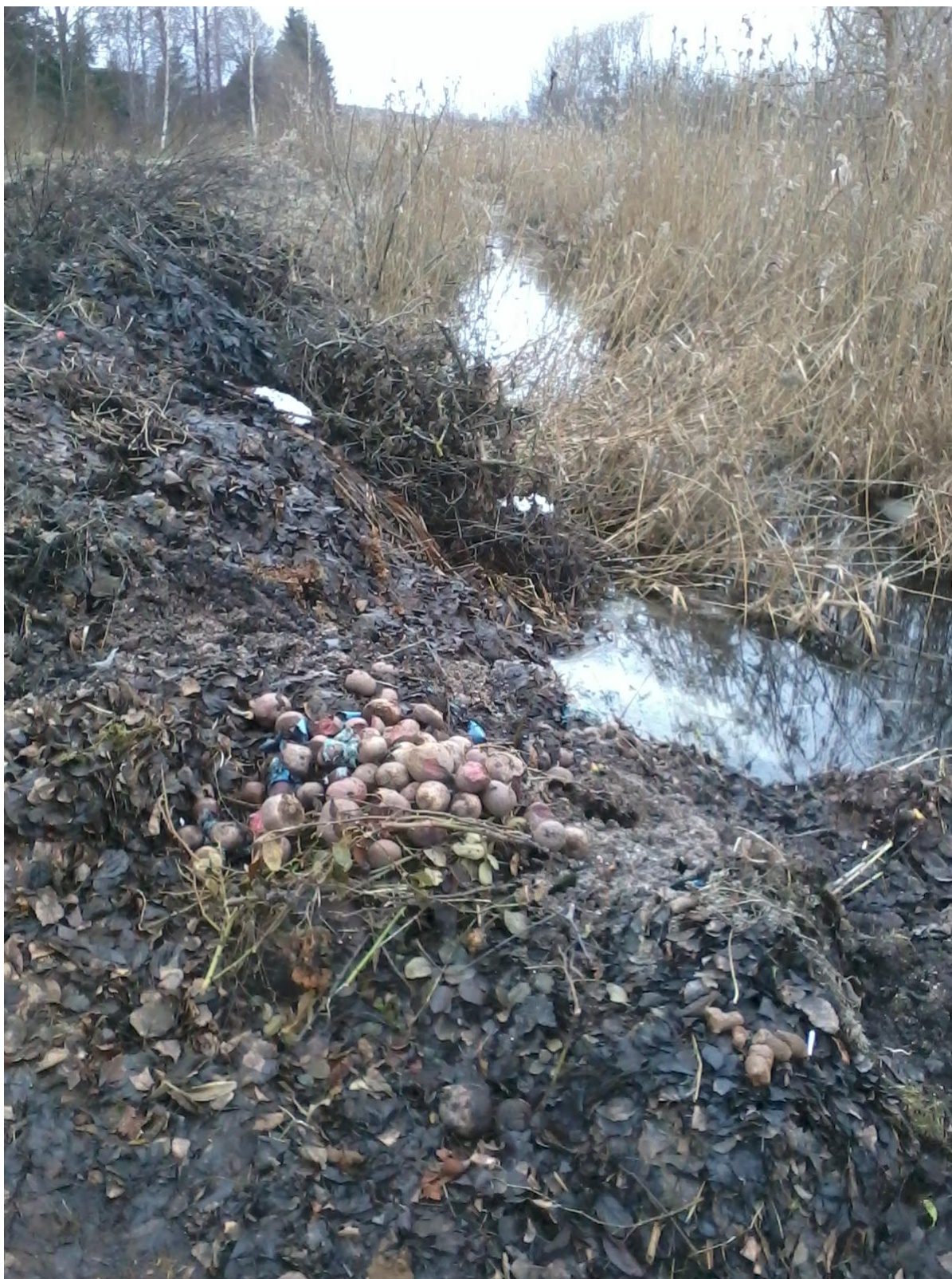
86 pav. Kanalo „aplinka“ ties Žiogų g. 2016-01-25 d.
