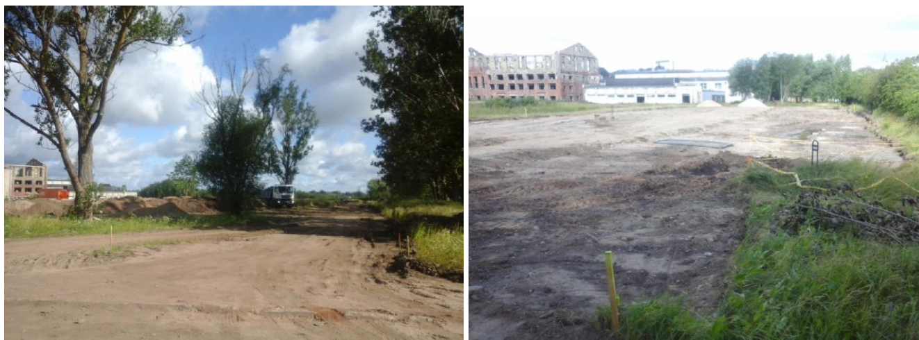
33 pav. Grunto kasimo darbai buvusios odų apdirbimo įmonės „Elnias“ teritorijoje 2020-07-09 d.
