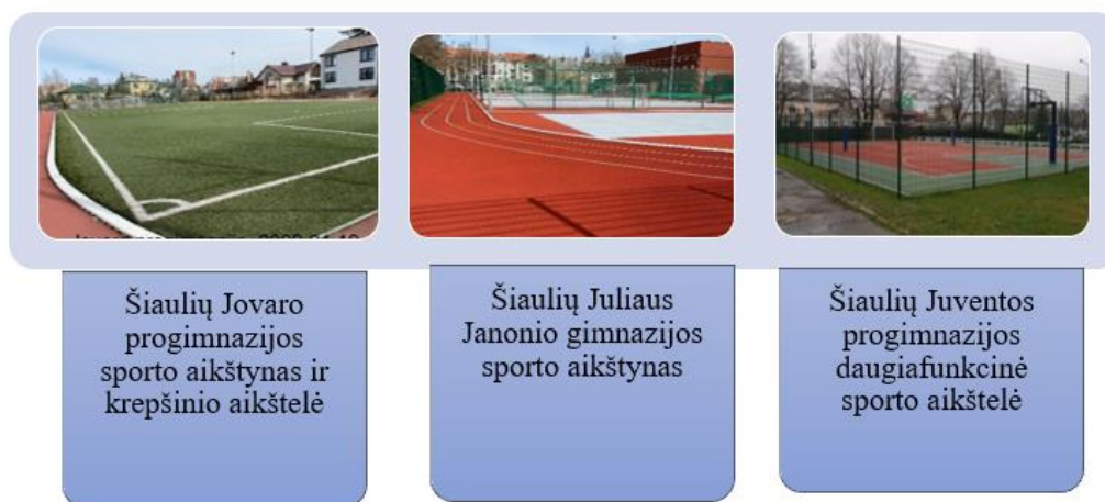
1. Pav. Švietimo įstaigų atnaujinti sporto aikštynai ir aikštelės
