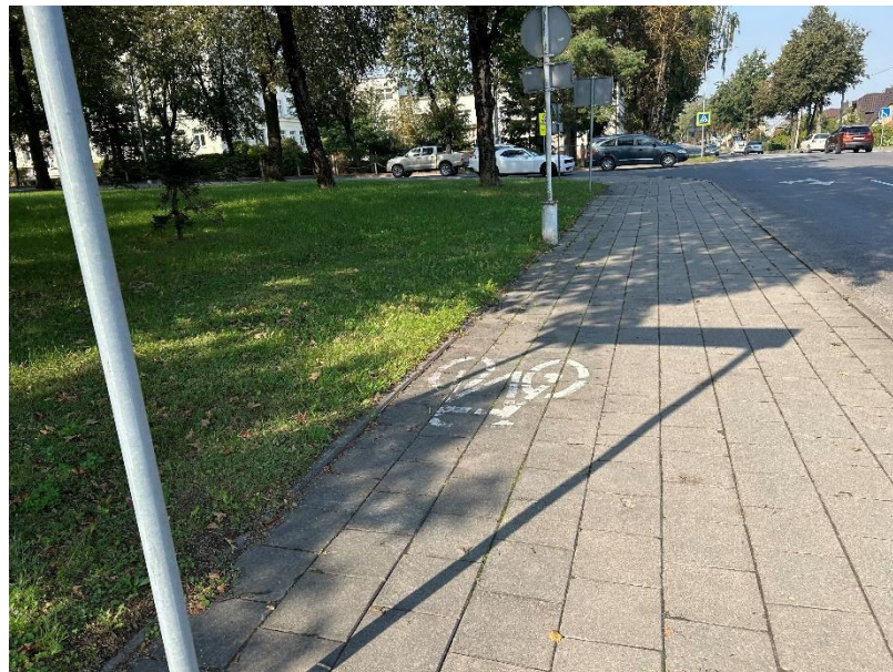
5 pav. Šaligatvis (ties S. Daukanto g. sankryža)
