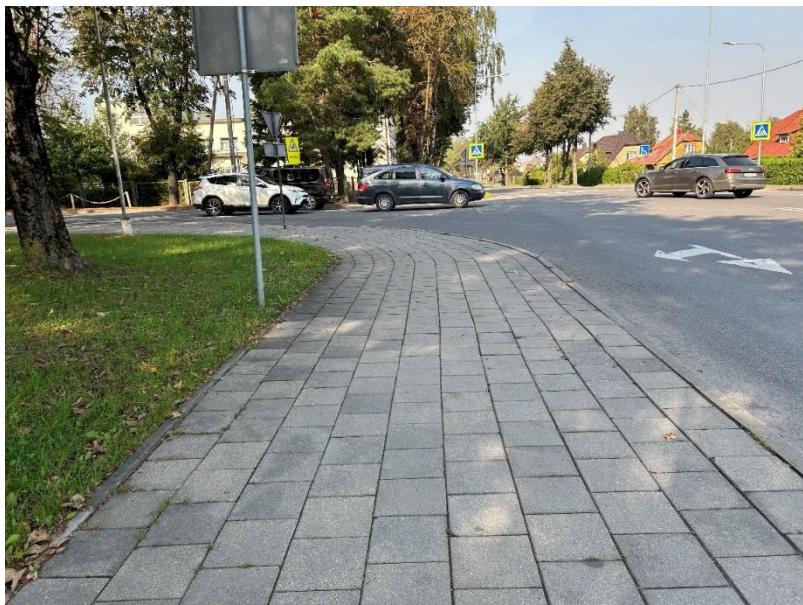
6 pav. Šaligatvis (ties S. Daukanto g. sankryža)
