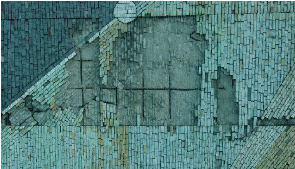
Pav. 8.3 Atviras armatūros tinklas po nubyrejusiais akmenukais
