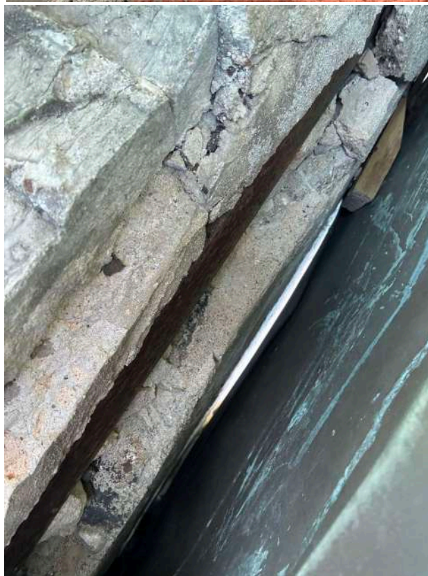
Pav. 8.6 Plyšiai šoniniuose segmentų sujungimo taškuose
