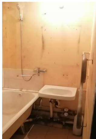
20 pav. 22-12-21 patalpos adresu Gegužių g. 48-90 prieš remontą
