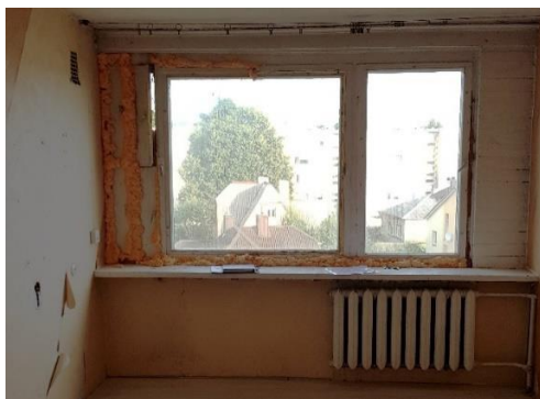
8 pav. 22-08-16 patalpos adresu Varpo g. 57-118 prieš remontą
