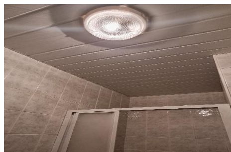
17 pav. 23-01-10 patalpos A. Mickevičiaus g. 36-5 po remonto
