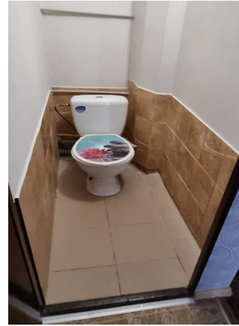
23 pav. 23-03-20 patalpos adresu Gegužių g. 48-90 po remonto
