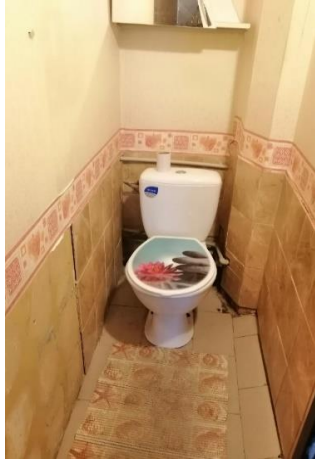
22 pav. 22-12-21 patalpos adresu Gegužių g. 48-90 prieš remontą
