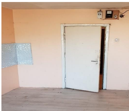
6 pav. 22-08-16 patalpos adresu Varpo g. 57-118 prieš remontą
