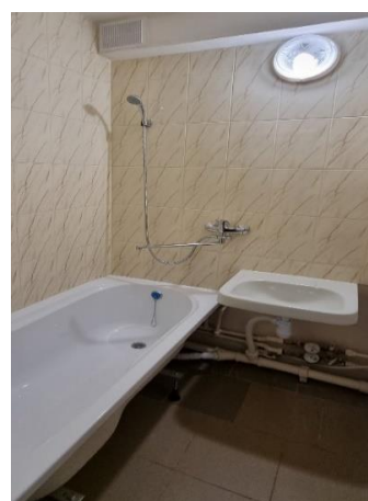
21 pav. 23-03-20 patalpos adresu Gegužių g. 48-90 po remonto
